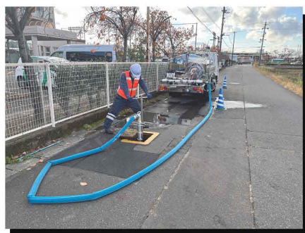
配水管から加圧式給水車へ補水
